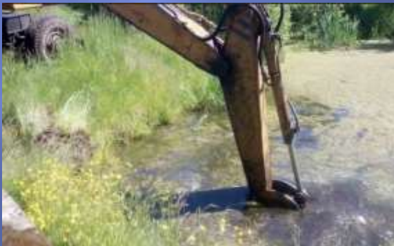
Углубление пожарных водоемов
